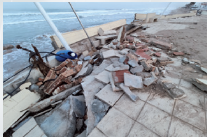
Estado del Paseo Marítimo de Bellreguard tras la tormenta.
